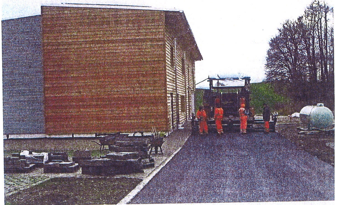
Zufahrt, Parkplätze und Außenanlagen des neuen Sportzentrums des Glonner Wintersportvereins sind fast fertig.
